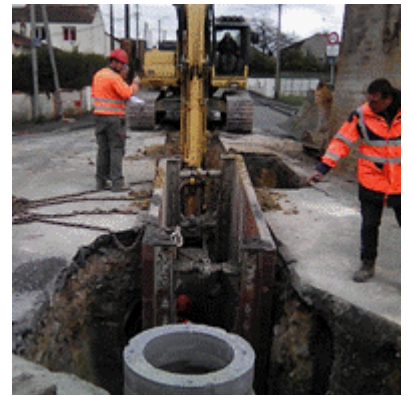
Figure 3 : renouvellement de réseau rue de la Plaine à Niort
