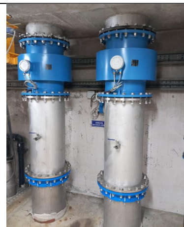
Fig.4c : Renouvellement des débitmètres entrée station Goilard
