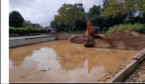
Figure 5a : terrassements bassin Espace Lambon (Niort)
