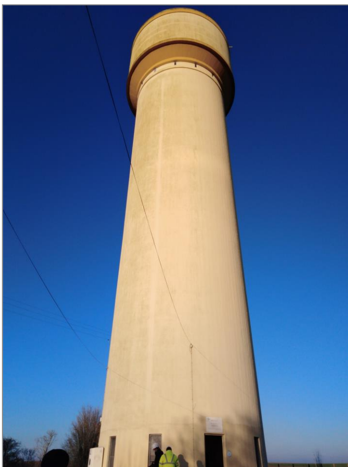
Réservoir La Jannerie – Le Bourdet
